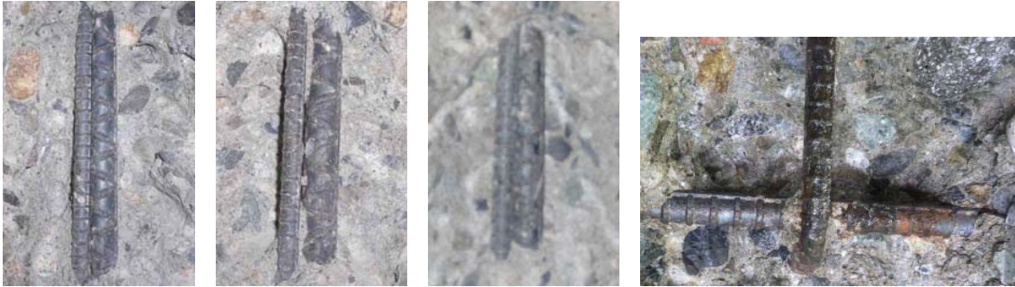
(a) PC1 (b) PC2 (c) PC3 (d) PC5 * PC1, PC2, PC3: No corrosion, ** PC5: Corrosion
